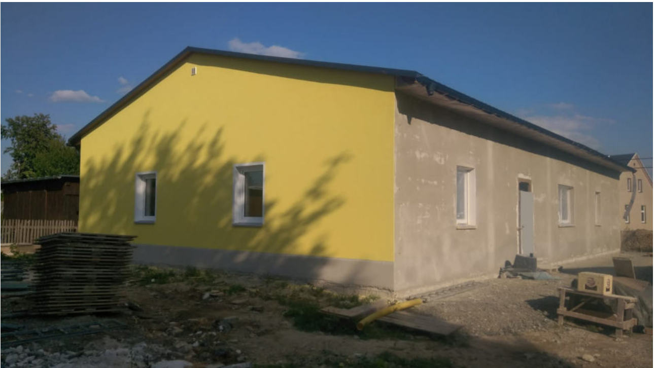
Nordost-Seite mit Oberputz
