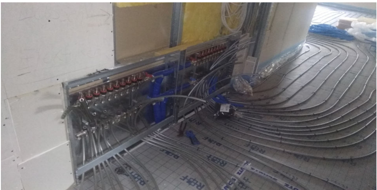
Verlegung der Fußbodenheizung
